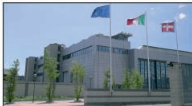
Figura 4 Il Centro Multi Funzionale Spaziale di ALTEC
